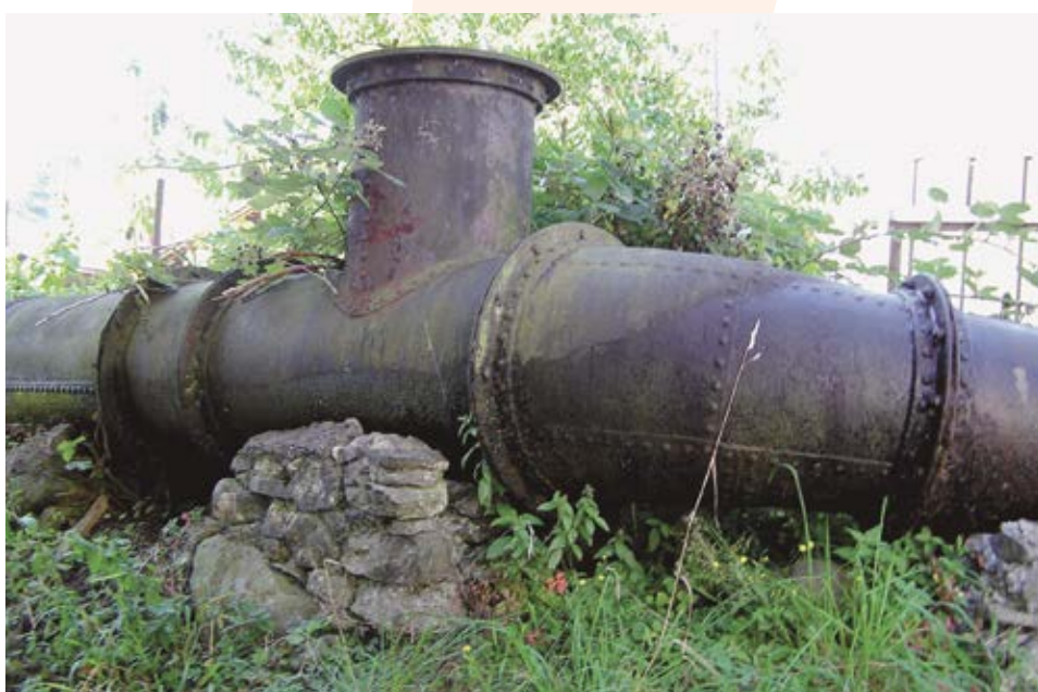
Steigrohr bei der ehemaligen Sägerei
