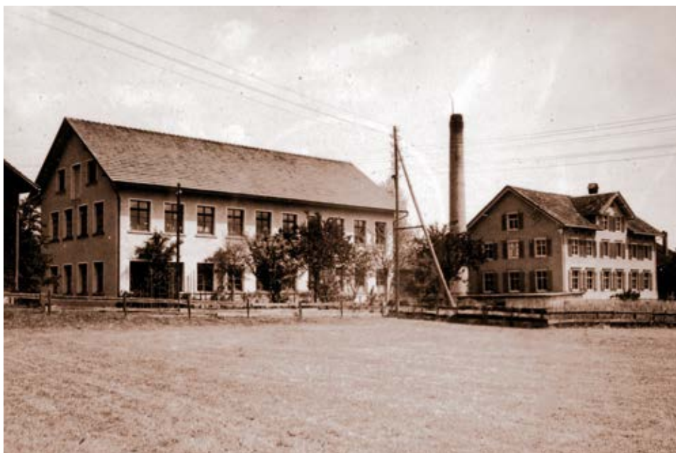
Neues und altes Fabrikgebäude
