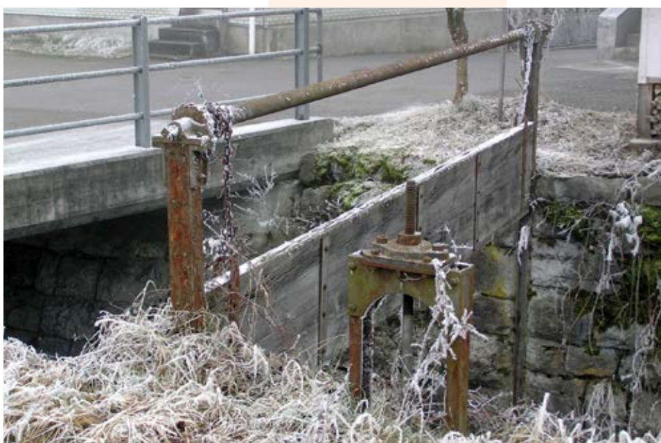
Feuerlöschfalle und Holand-Kanal-Schieber
