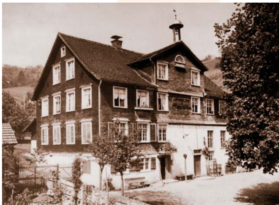
Gasthaus und Mühle vor dem Umbau
