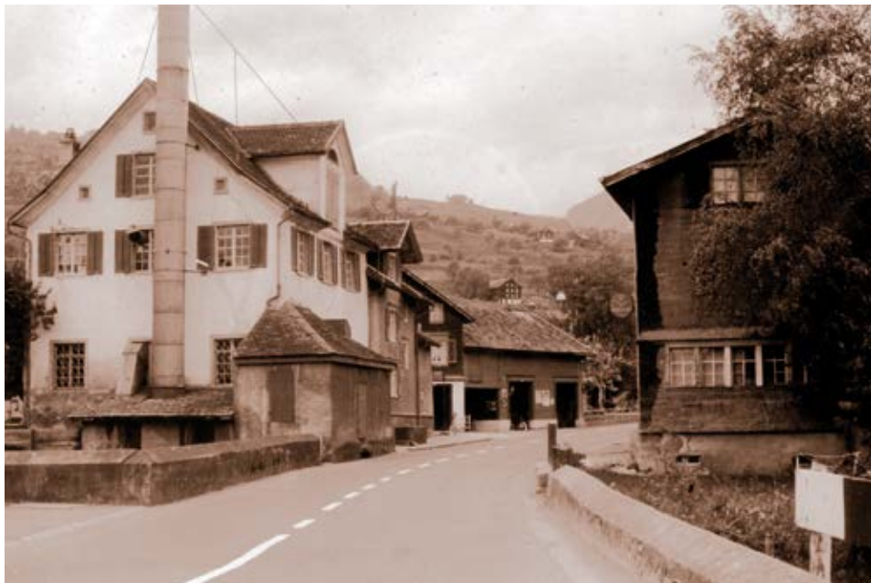
Reisserei mit Staubkamin und Wasserradhaus
