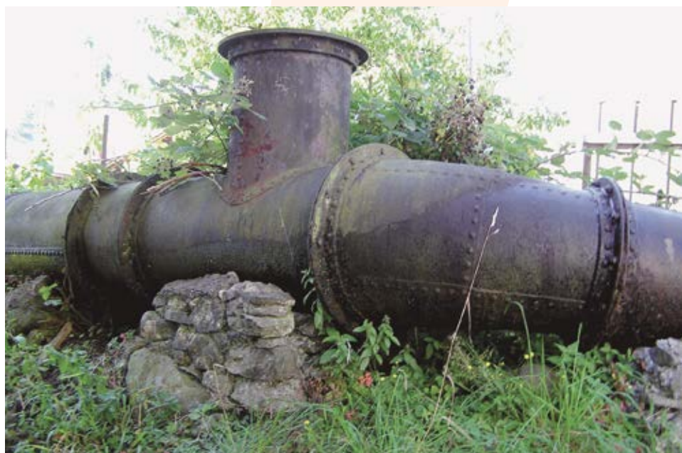
Steigrohr bei der ehemaligen Sägerei
