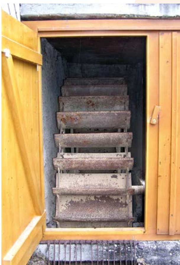
Noch vorhandenes Wasserrad
