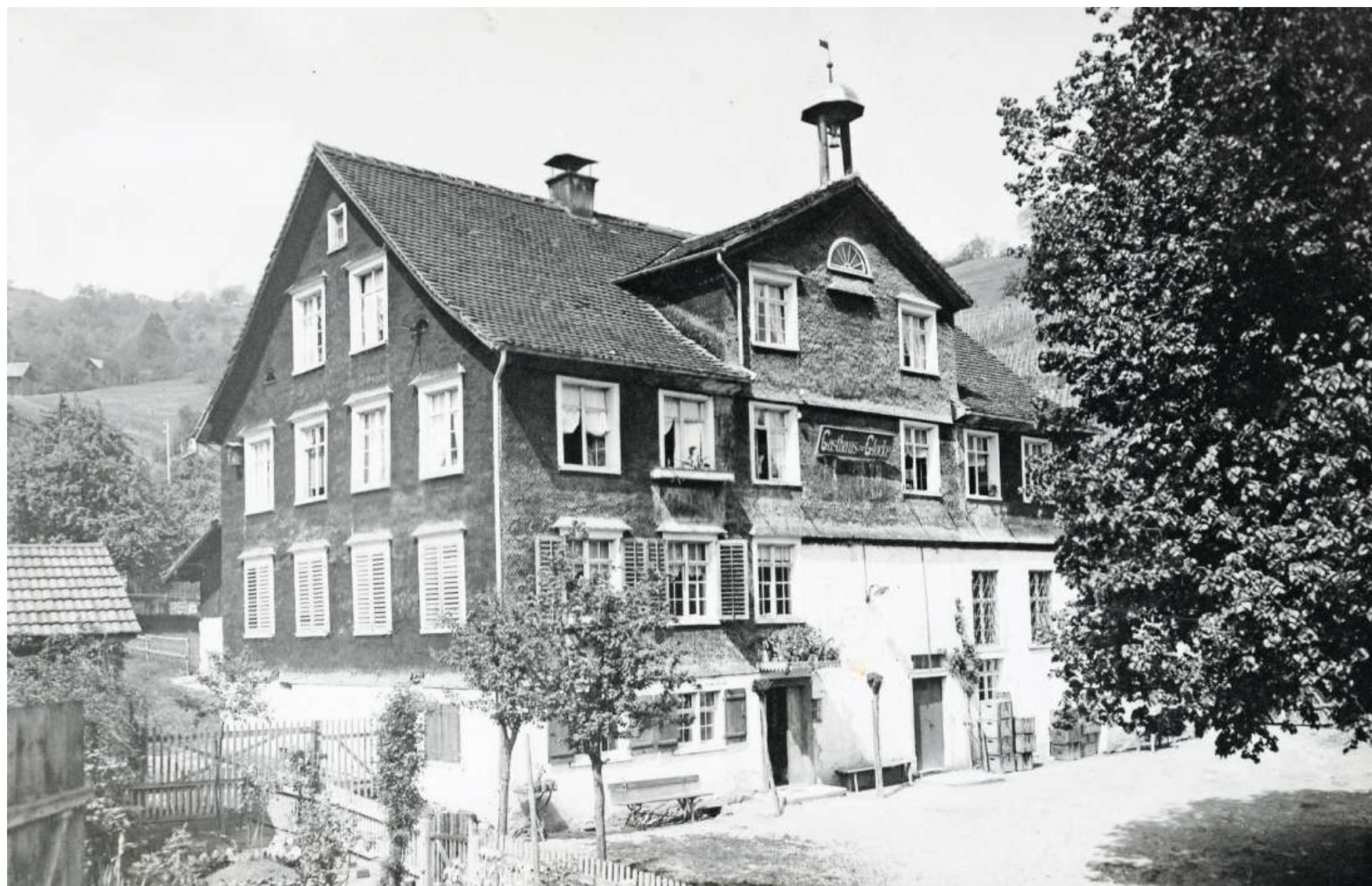
Das einstige Gasthaus zur Glocke, gut sichtbar ist der Dachreiter mit dem Glöcklein.
